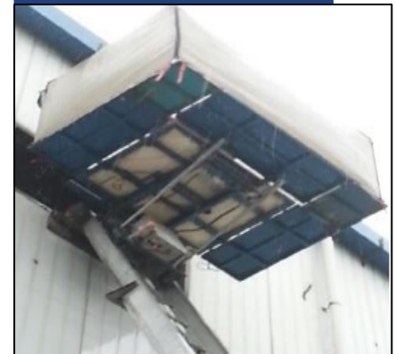
반출입구 tarpaulin 천막 설치
