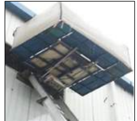
반출입구 tarpaulin 천막 설치
